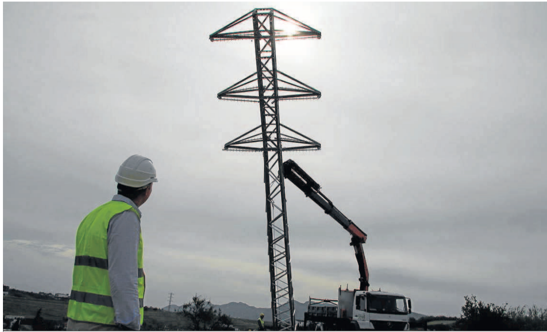
Operación de alzado de una de las torres de distribución.
